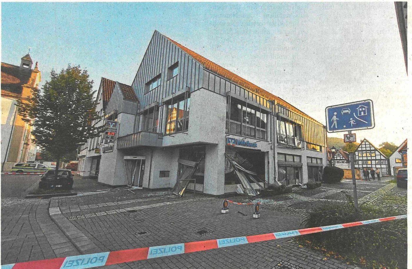
Scherben und Flatterband rund um die Volksbankfiliale in der Mittleren Straße.
